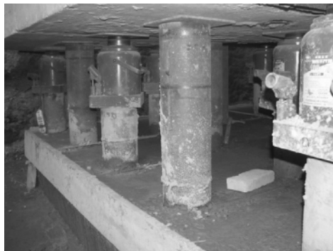
图 6 坑式静压桩
