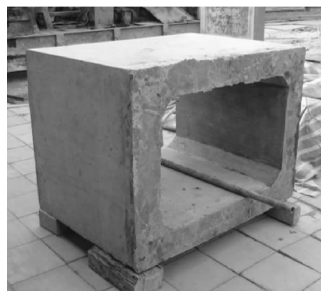
图2 手掘式顶管中所用箱梁
