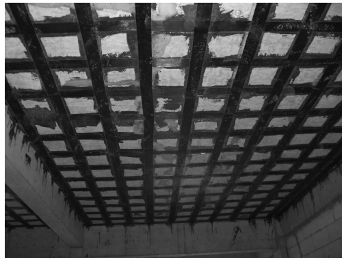
图6 碳纤维布加固楼板效果图
