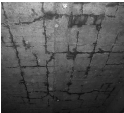
图4 楼板开裂示意图
