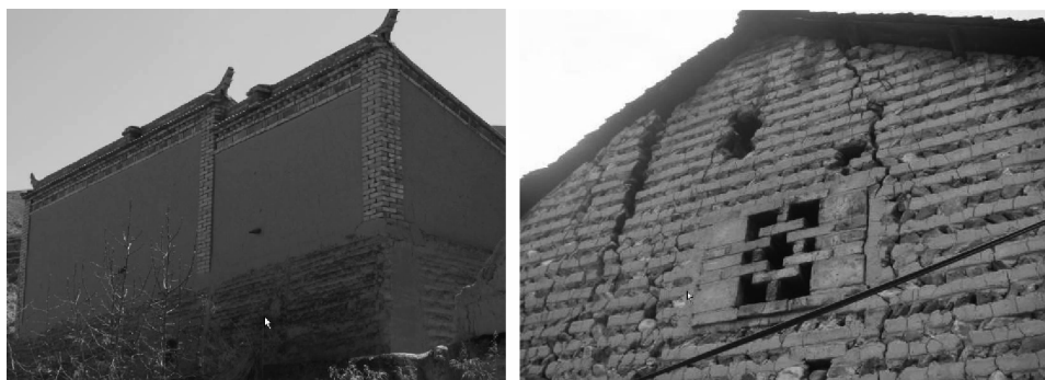
图5 墙体材料混用
