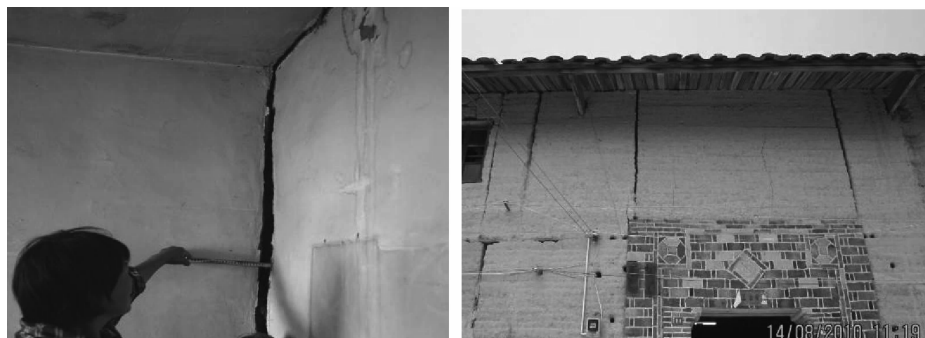
图4 生土墙体之间无可靠连接
