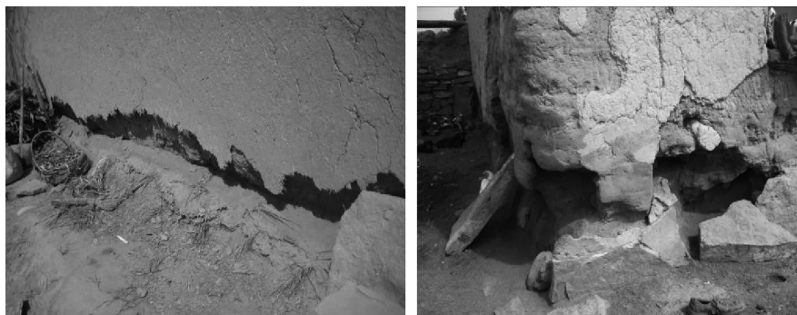
图2 生土墙体根部碱蚀现象
