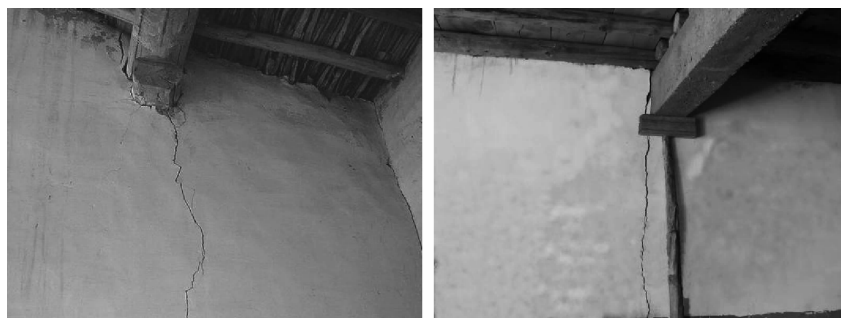
图3 生土墙体局部受压承载力不足
