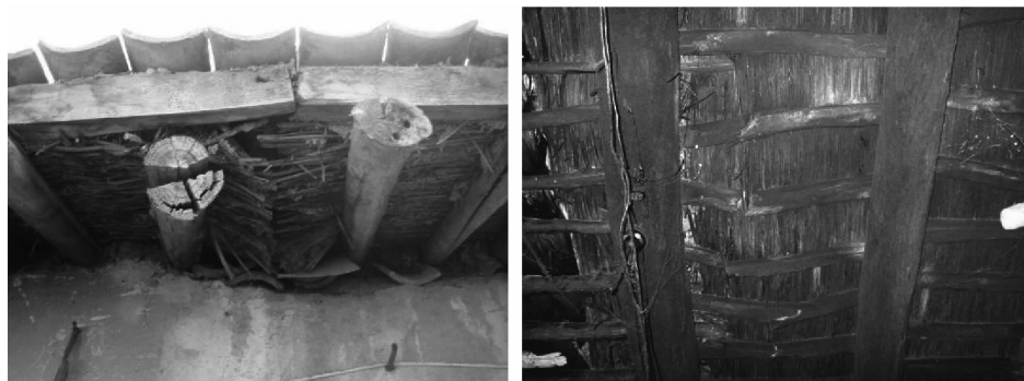
图6 楼屋面木构件腐朽、破损
