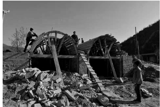
图 3 石砌箍窑的覆土过程
