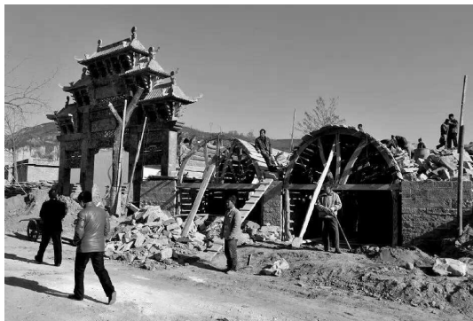
图 1 石砌箍窑的石作工艺
