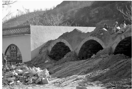
图 2 石砌箍窑的支模工艺
