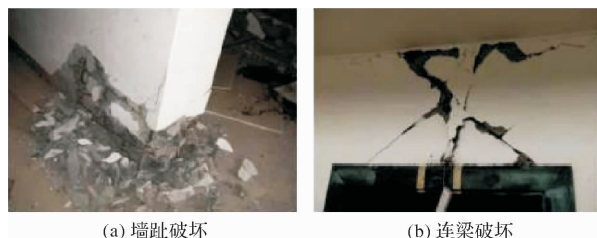
图 1 剪力墙的典型破坏
