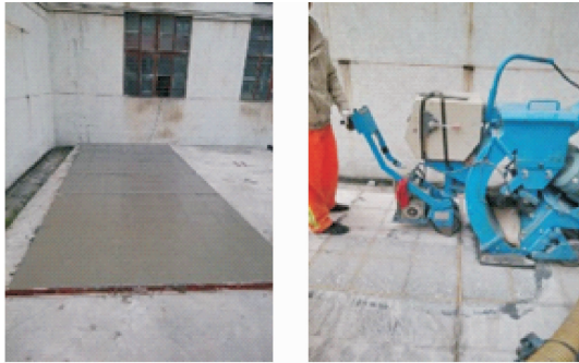
图 1 混凝土板成型与抛丸
