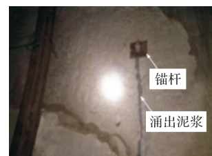
图8 锚杆孔泥浆涌出现象
