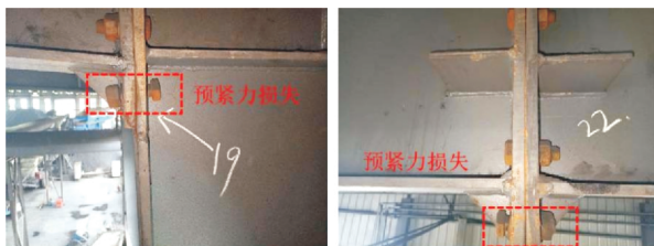
图1 某厂房端板节点螺栓预紧力缺失典型案例
