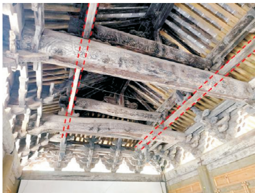
图18 献殿室内东向视角照片(红色为榑下穿枋)
