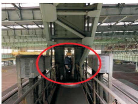
图 4 B 列/25~26 轴间上柱柱间支撑屈曲变形
