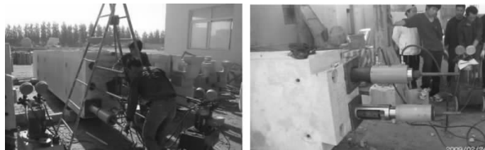
图 5 主梁预应力张拉过程
