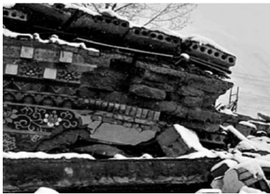
图 18 预制板叠压 Fig. 18 Overlying the precast slab
