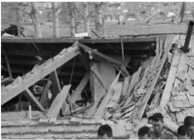
图 8 屋架檩条坠落
