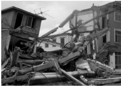
图 15 墙体倒塌后圈梁下坠
