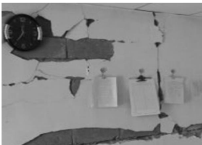
图 20 气象局办公室墙面出现裂缝 Fig. 20 Damage of the wall
