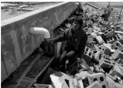
图 23 墙倒导致楼盖塌落 Fig. 23 Damage of the wall
