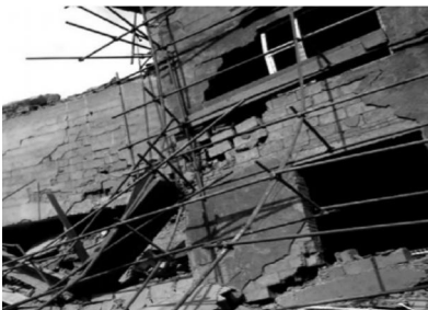
图 19 未设构造柱导致破坏 Fig. 19 Damage without tie column
