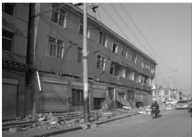
图 24 上部砌体出现裂缝 和破坏 Fig. 24 Damage of the upper masonry structure
