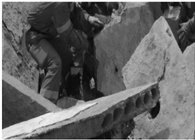
图 12 预制楼板被折断
