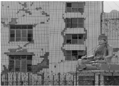
图 11 窗下墙出现 X 形裂缝
