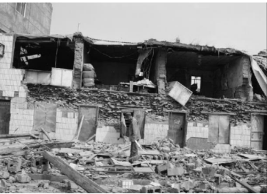
图 10 房屋外纵墙外闪倾倒
