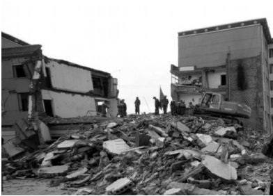
图 14 L 型房屋角部破坏
