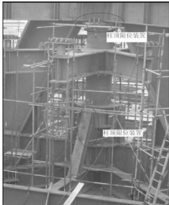
图 2 柱顶和柱底水平限位装置
