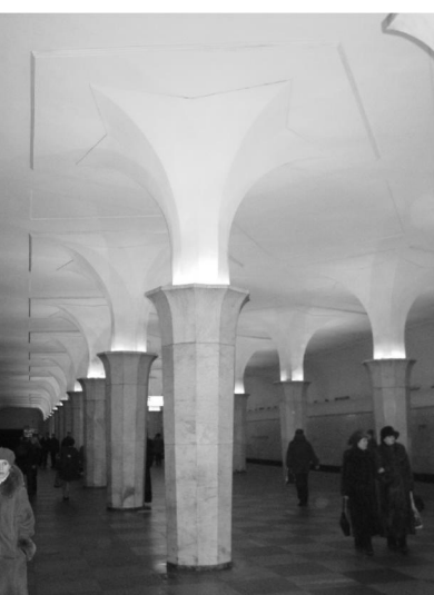
图 5 克罗波特斯卡娅地铁站 无梁楼盖结构形式 Fig. 5 Flat slab floor structure of Кропоткинская subway station
