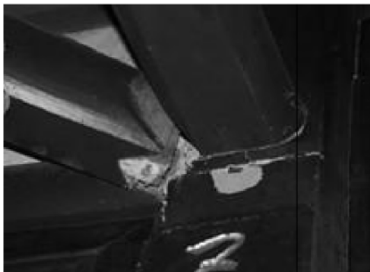
图 6 榫卯节点破坏
