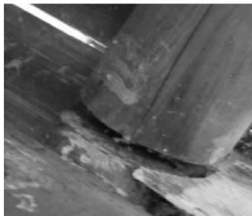
图 9 柱脚滑移
