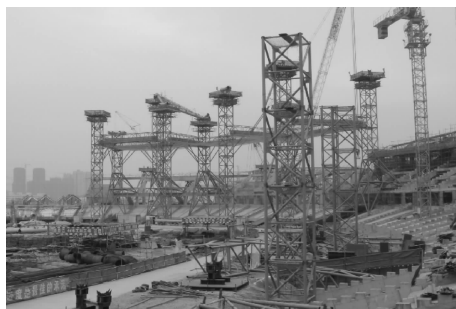
图7 现场内环支撑的安装
