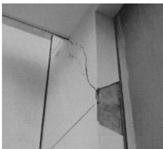
图2 裂缝处墙皮脱落
