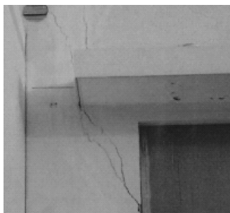
图1 厂房南门出裂缝
