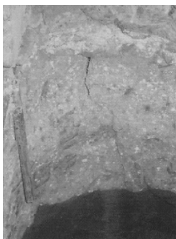
图 7 从下到上裂缝由宽变窄 Fig. 7 The crack narrows upward
