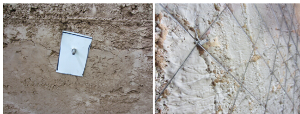
(a) 背面加垫板螺杆固定 (b) 正面绑扎固定
