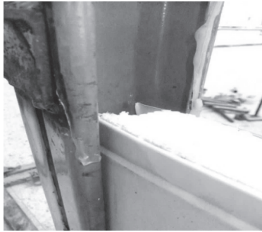
(a) 墙面板与立柱的实际连接构造
