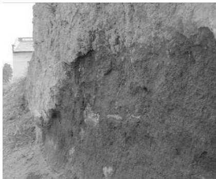
图 1 黄土边坡冻融剥落破坏
