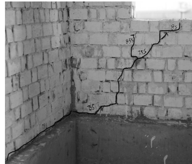
(a) 背立面与左立面内墙底部裂缝
