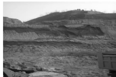
(c) 甘泉县城某基坑开挖边坡冻融层状剥落
