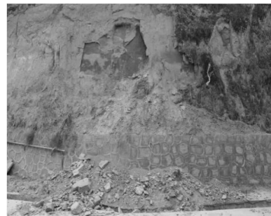
(a) 黄陵县中立石油加油站边坡冻融层状剥落
