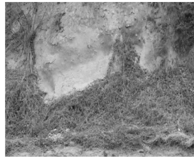
(a) 黄店复线边坡表层冻融剥蚀
