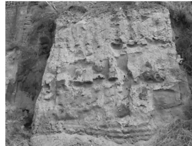
(b) 延川县城某居民区边坡表层冻融剥蚀
