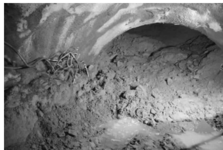
图2 桃树坪隧道施工中涌水现象
