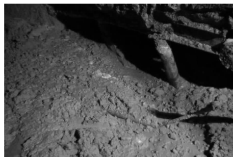
图3 桃树坪隧道施工中涌沙现象
