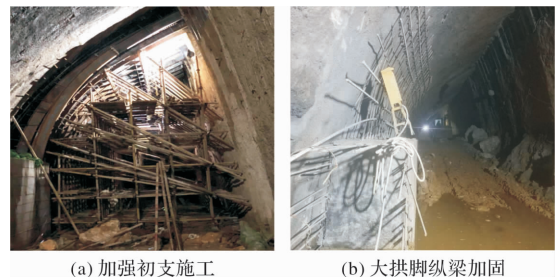
(a) 加强初支施工 (b) 大拱脚纵梁加固
