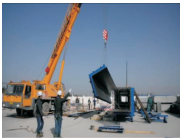
图 11 钢筋笼与模板拼装
