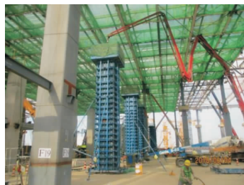
图 14 柱混凝土浇筑
