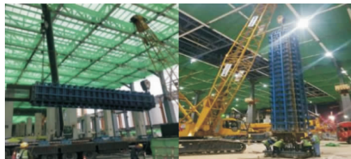
图 13 柱钢筋笼与模板整体吊装施工
