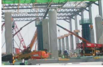
图 15 柱混凝土保湿养护
