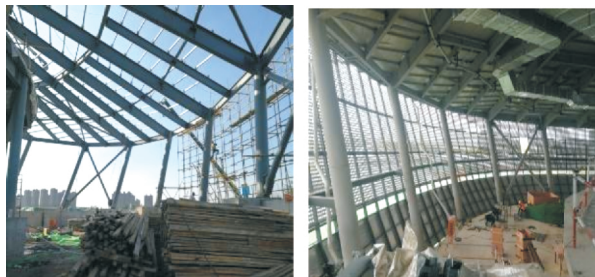
图14 表皮龙骨和表皮单元钢结构施工现场照片
