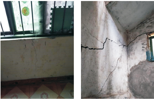
(a) 前缘段房屋裂缝(F20) (b) 后缘段房屋裂缝(F6)
